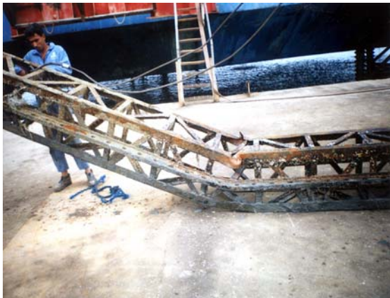
شکل ۷- پایه جک‌آپ ساحل ۱۱۰ پس از حادثه
